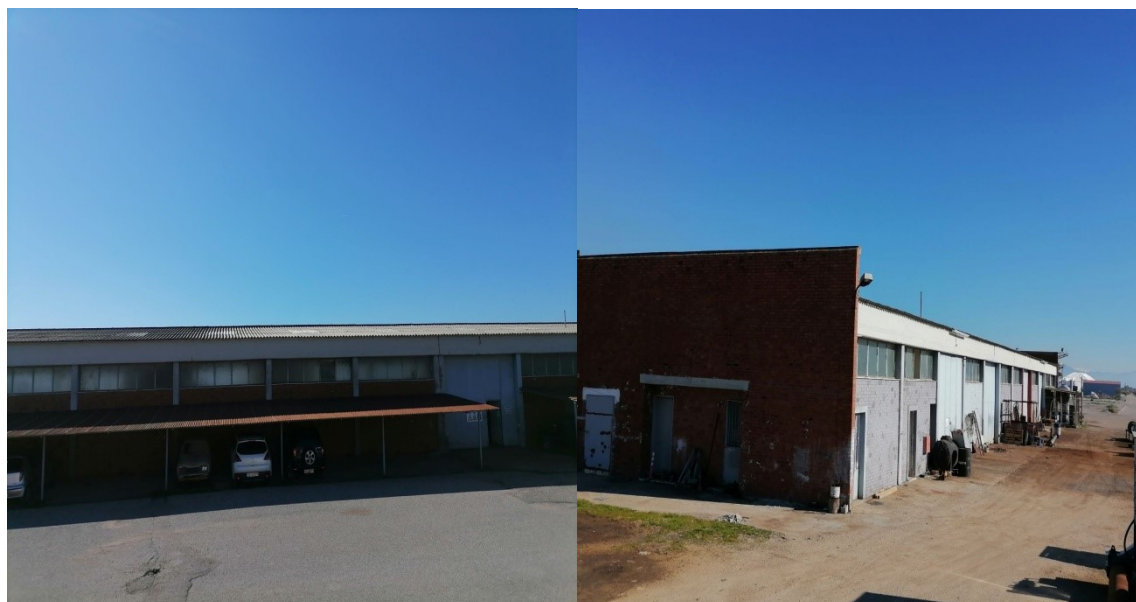
Απόψεις του κτηρίου συνεργείων - αποθήκης
